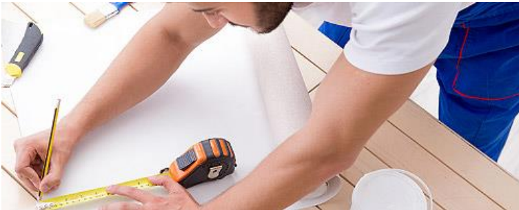
Строительные работы и ремонт помещений
